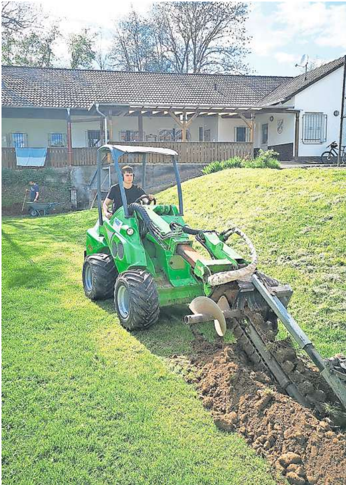
In Eigenleistung verlegten die Kleinselheimer auf dem Sportplatz 400 Meter Wasserleitung.
